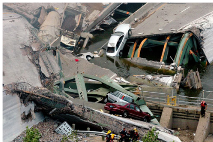
Zřícený most přes řeku Mississippi, Minneapolis, srpen 2007
