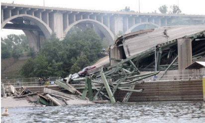
Zřícený most přes řeku Mississippi, Minneapolis, srpen 2007
