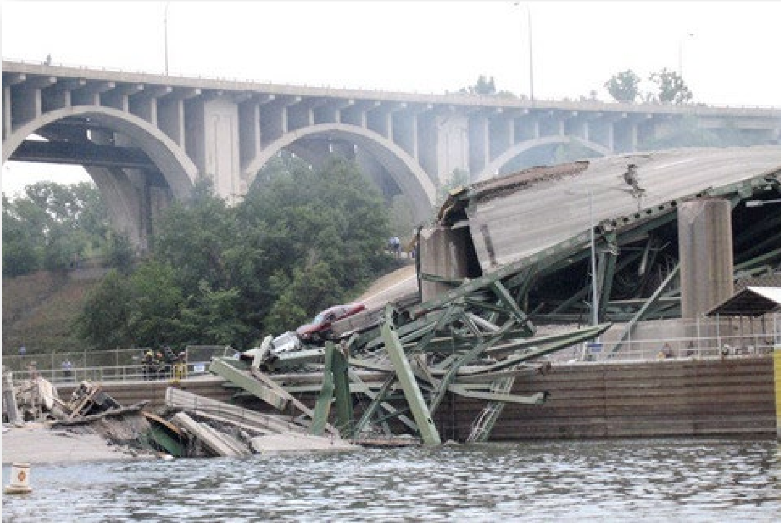
Zřícený most přes řeku Mississippi, Minneapolis, srpen 2007
