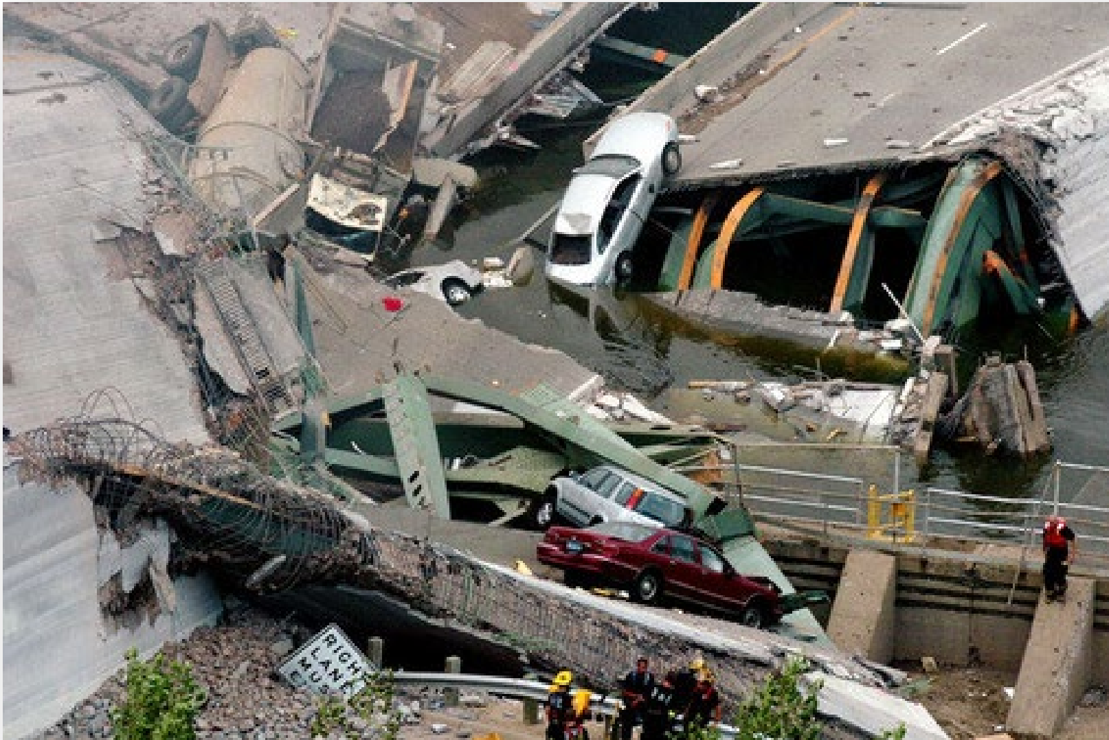
Zřícený most přes řeku Mississippi, Minneapolis, srpen 2007
