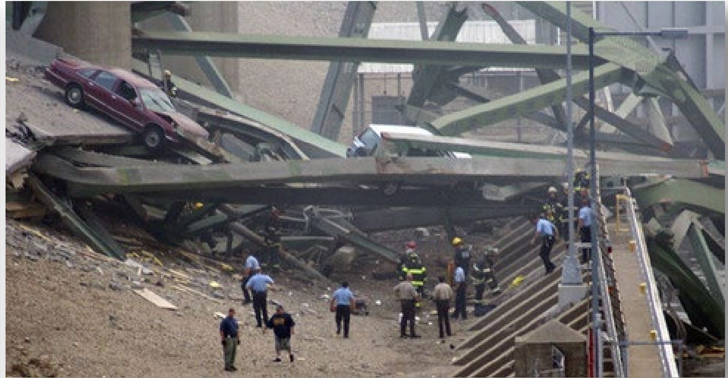
Zřícený most přes řeku Mississippi, Minneapolis, srpen 2007
