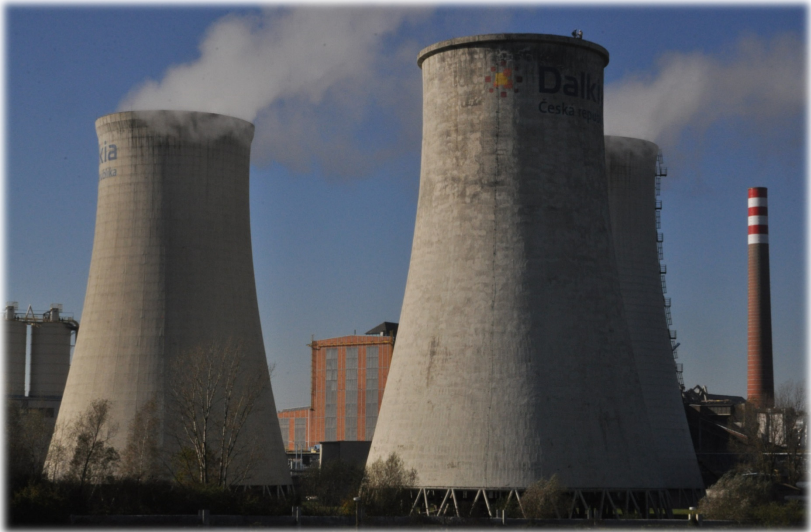
Hyperbolické chladicí věže, elektrárna Ostrava-Třebovice, 1931-1933, 1956, 2001
