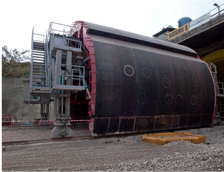
Obr. 63 Pojízdné bednění pro betonáž tunelového ostění (převzato z http://www.marquel.net )
