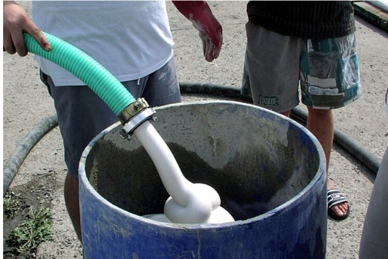
Obr. 47 Technická pěna používaná pro vylehčení pěnobetonu (převzato z http://www.bvgroup.cz )
