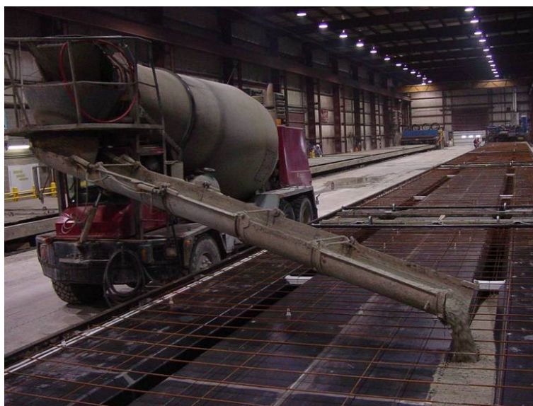
Obr. 56 Sekundární doprava samozhutitelného betonu z autodomíchávače pomocí skluzu (převzato z http://blog.highconcrete.com )
