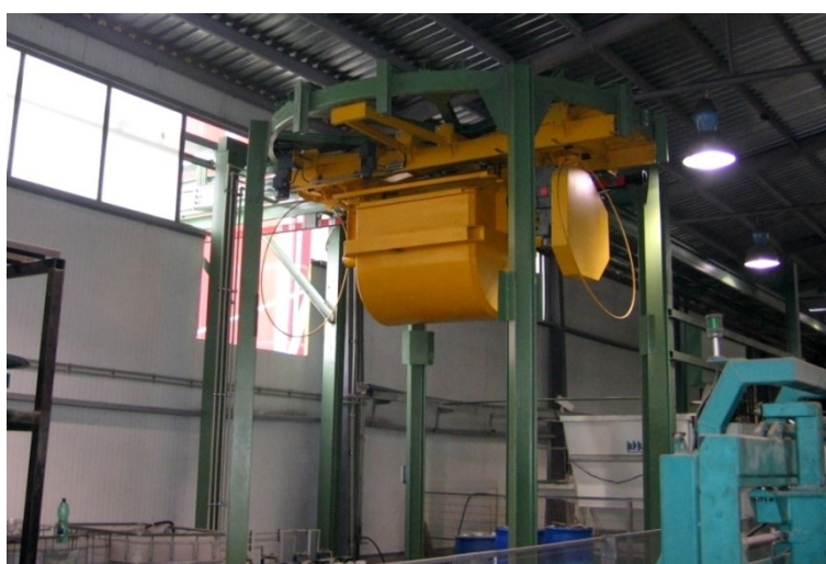
Obr. 60 Sekundární doprava betonu podvěsnými vozíky ve výrobě prefabrikátů (převzato z http://www.prefa.cz )
