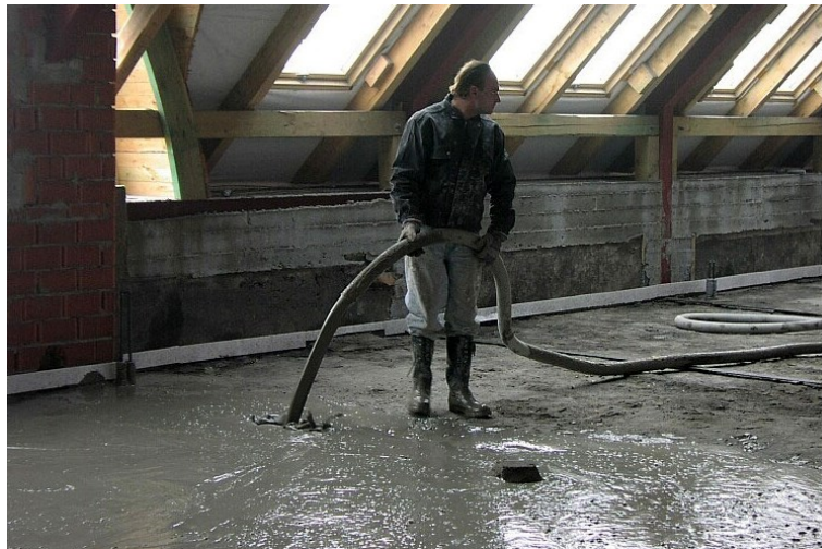
Obr. 48 Aplikace pěnobetonu při realizaci půdní vestavby (převzato z http://www.bvgroup.cz )
