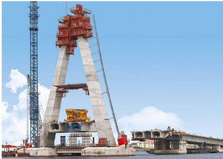
Obr. 62 Betonáž mostního pylonu pomocí šplhavého bednění (převzato z http://www.peri.cz )
