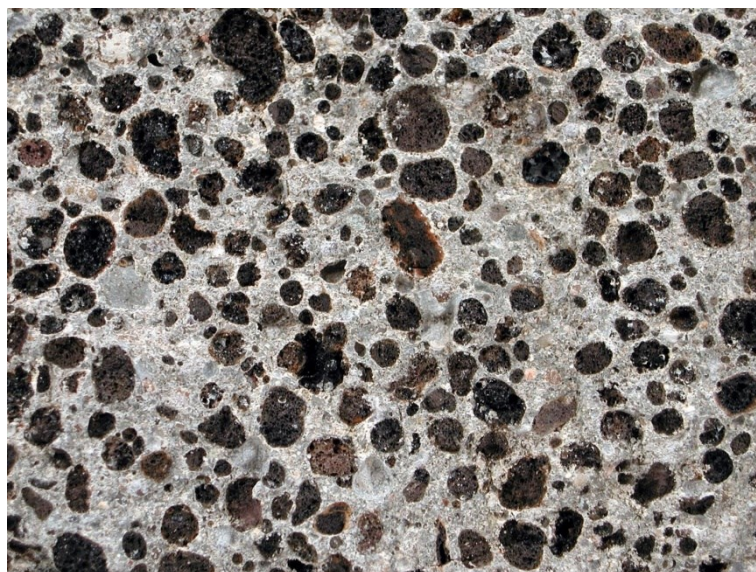
Obr. 36 Řez vzorkem liaporbetonu - nepřímě lehčeného lehkého betonu s pórovitým kamenivem Liapor
