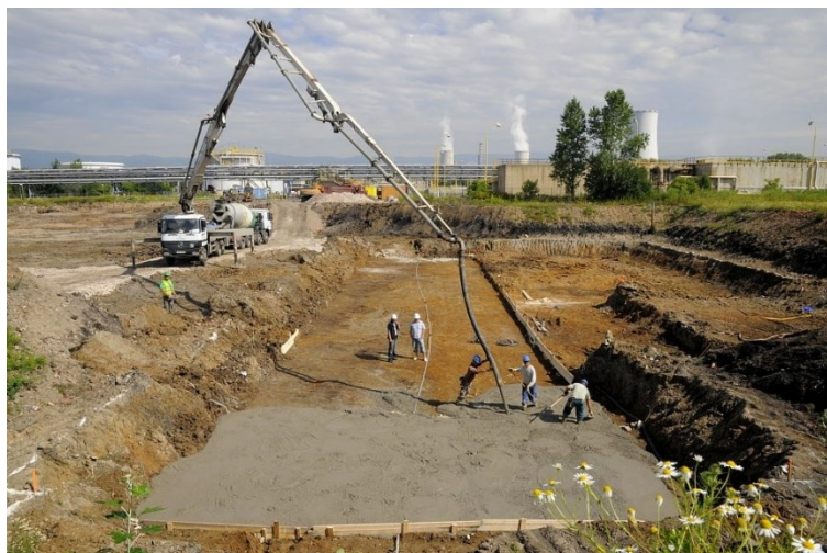
Obr. 59 Sekundární doprava betonu čerpáním (převzato z http://www.lite-smesi.cz )
