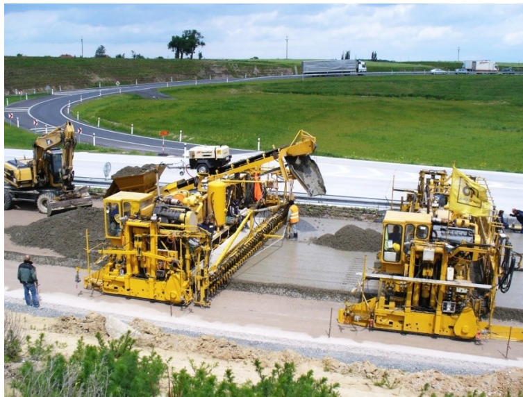
Obr. 49 Pokládka cementobetonového krytu dálnice moderními finišery (převzato z http://www.dalnice.com )
