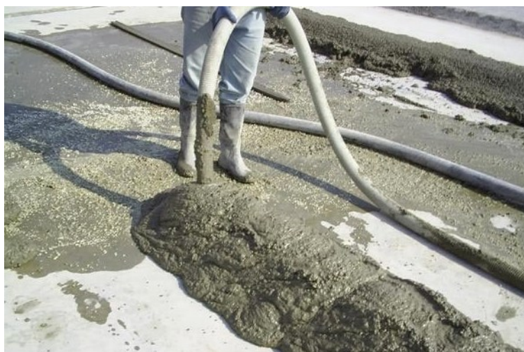
Obr. 40 Ukládání čerstvého polystyrenbetonu čerpáním (převzato z http://www.sircontec.com )
