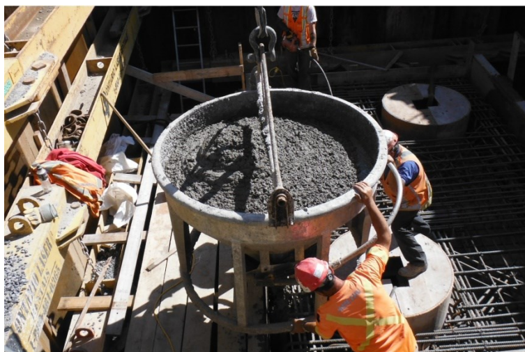
Obr. 57 Sekundární doprava betonu jeřábem v koši (převzato z http://www.pontcornwallbridge.ca )
