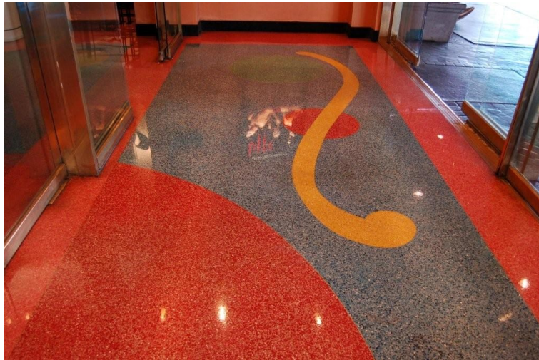
Obr. 54 Dekorativní podlaha z polymerbetonu, tzv. syntetické teraco (převzato z http://www.trey.cz )
