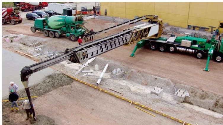
Obr. 58 Sekundární doprava betonu pásovým dopravníkem (převzato z [28])
