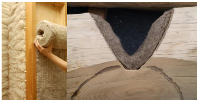
Obrázek 02: zateplení příčky ovčí vlnou (foto převzato z: http://www.isolena.cz )
