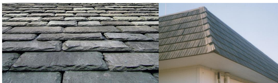
Obrázek 03: břidlicová střešní krytina a cementem pojené střešní tašky, plněné dřevěnými třískami (střecha v kalifornii)
